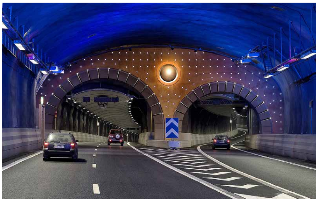
Bergmaterial i berget, Södertunneln i Stockholm.
