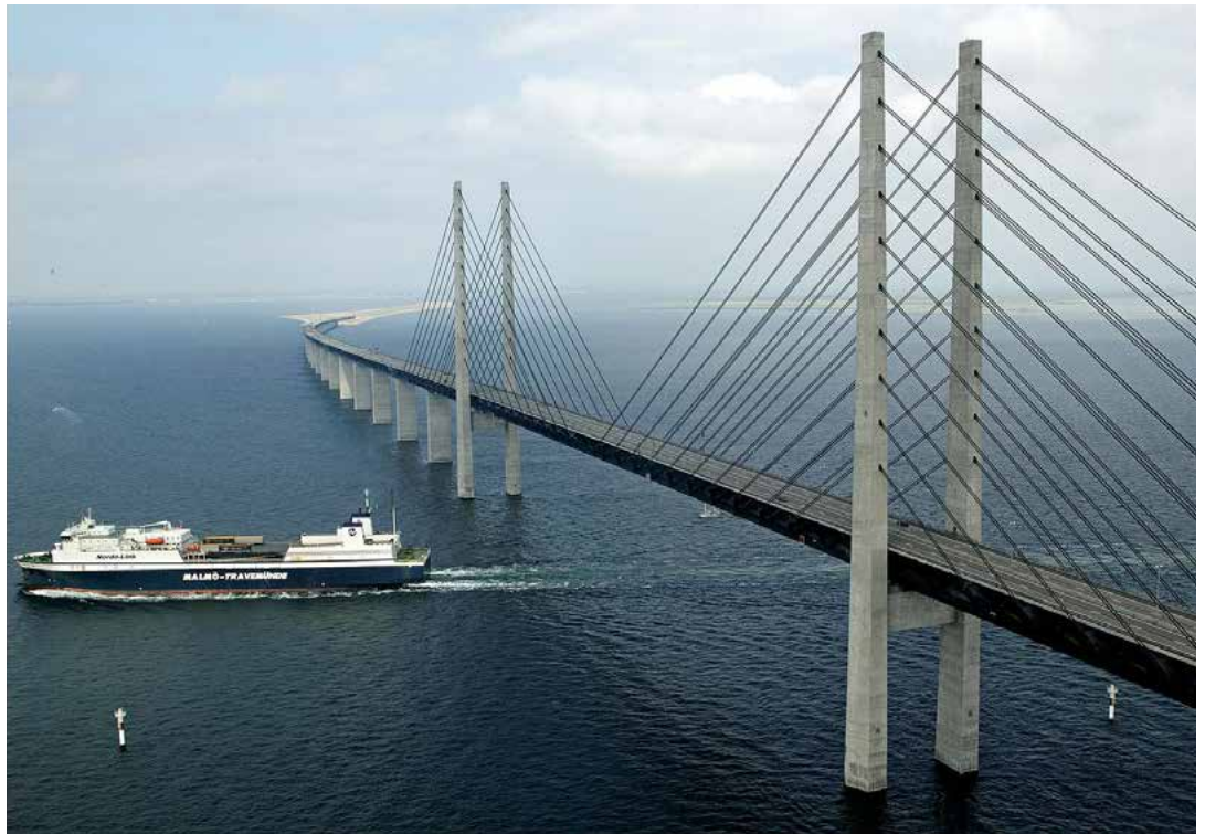
Öresundsbron. Pylonerna av betong är 204 meter höga.
