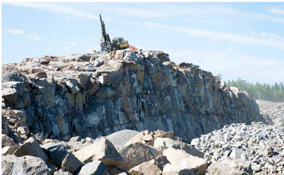
En pallsprängning görs i ett antal "trappsteg", där man först spränger ett trappsteg, och när det är omhändertaget så spränger man ett nytt. Pallarna är ofta mellan tio till tjugo meter höga, flera meter djupa och flera tiotals meter breda.
