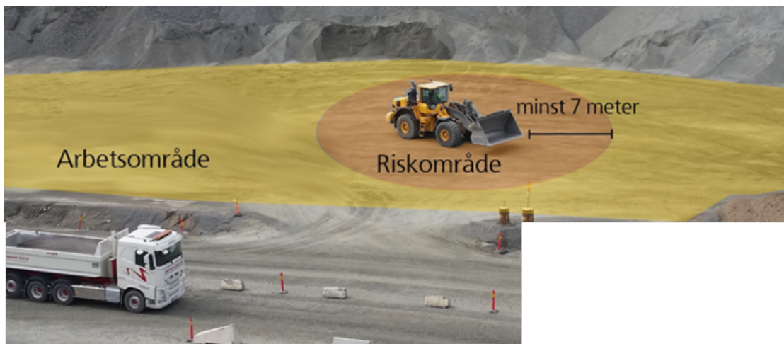
Figur 2: Hjullastarens arbets- och riskområde. Källa: Skanska.
