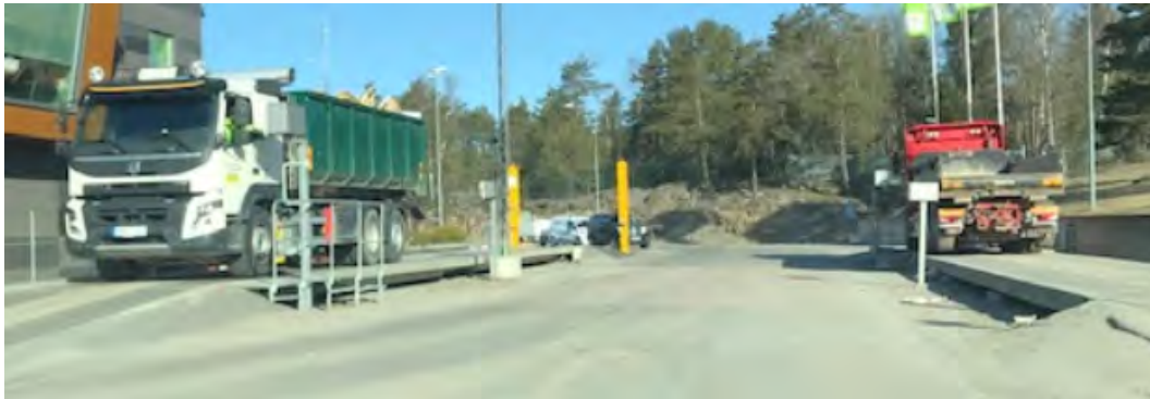
Figur 11: Exempel på stålkonstruktion på sidan om väg.
