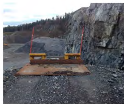
Figur 21: Exempel tippplåt/ backskydd, Källa: Skanska. Exempel förbudsskylt (förbud att tala i mobil) som placeras vid infart till tippområdet. Källa: Skanska.
