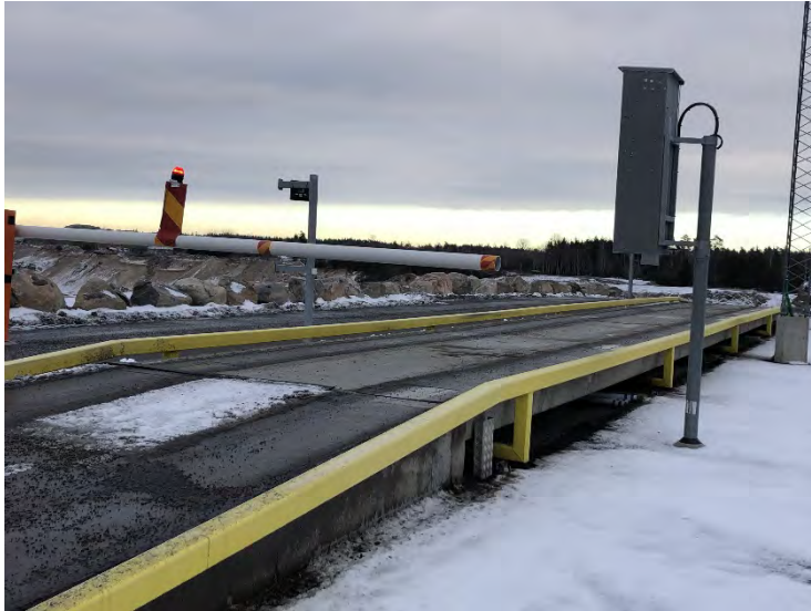
Figur 12: Exempel på stålkonstruktion på sidan om väg.
