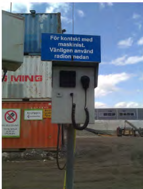
Figur 10: Exempel kommunikationsstolpe i tåkt. Källa: Skanska
