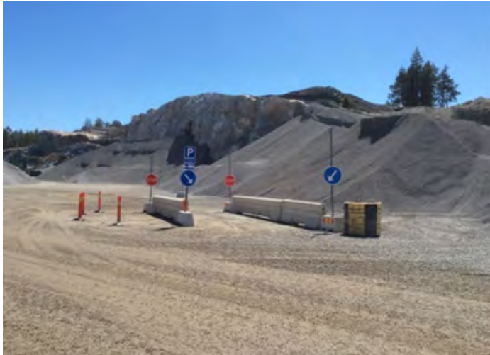
Figur 19 och 20: Exempel lastzon inkl. skyltning och barriärer, Källa: Skanska.
