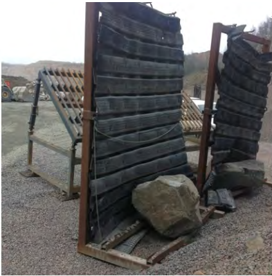
Figur 28 och 29: Exempel på fysiska hinder mot stensprut. Källa: Skanska.
