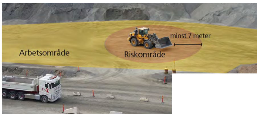
Figur 31: Figur x Hjullastarens arbets- och riskområde. Källa: Skanska.
