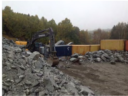
Figur 28 och 29: Exempel på fysiska hinder mot stensprut. Källa: Skanska.
