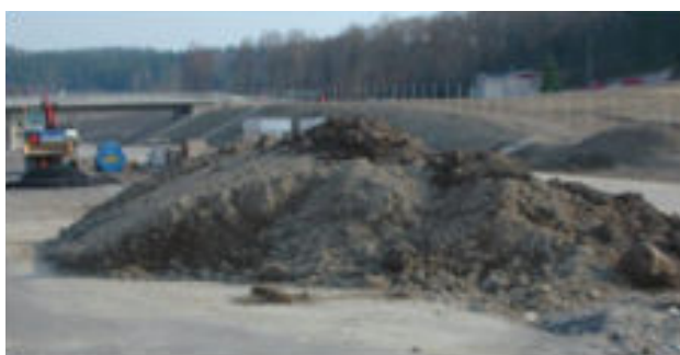
Figur 10. Exempel på nedsmutsning av färdigpackat bärlager genom a) spill av jord och b) upplag med jordmassor.
