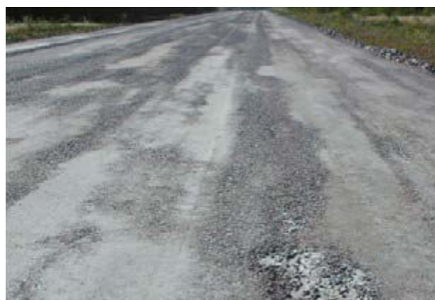
Figur 6. Separation av bärlager beroende på ovarsam utläggning och torrt material.
