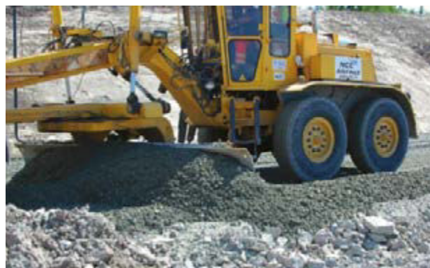
Figur 5. Exempel på utläggning av bärlager
