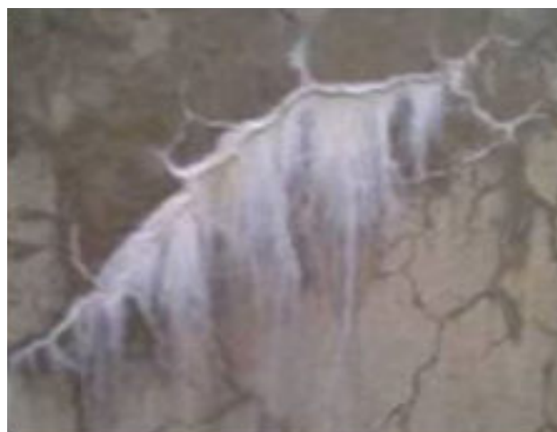
Figur 14. Exempel på sprickor i betong orsakade av a) alkalisilikareaktion och b) alkalisilikareaktion i kombination med frost.
