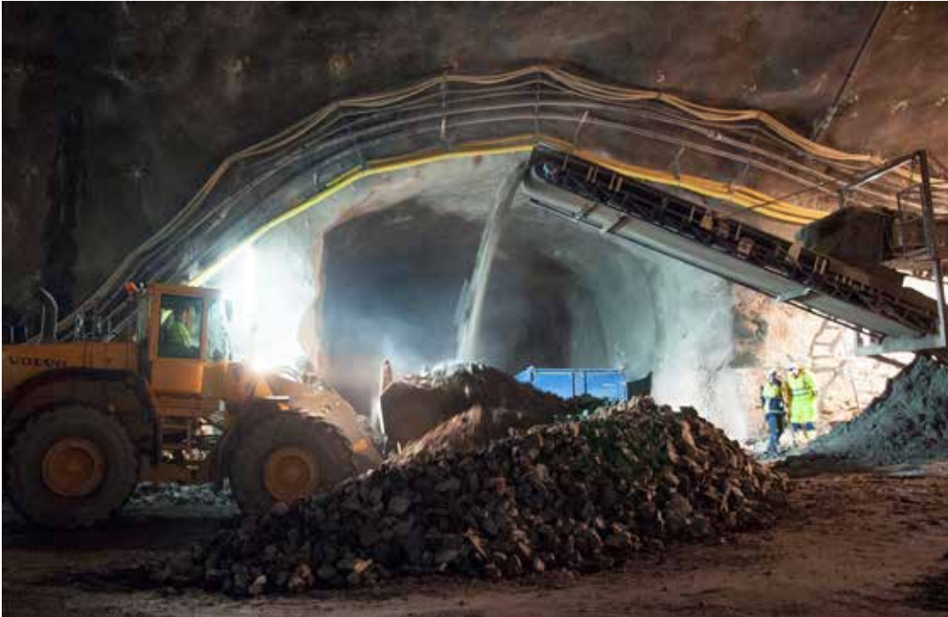
Med hjälp av mobila krossar kan bergmaterial tillverkas på plats och man undviker onödiga transporter.
