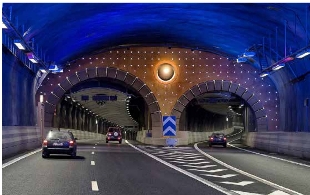
Bergmaterial i berget, Södertunneln i Stockholm.
