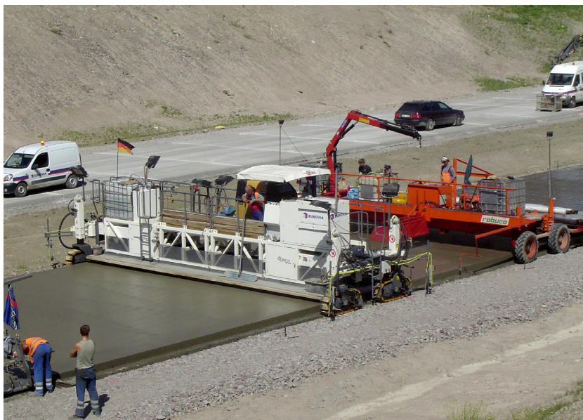
Figur 26. Sammanpressning och ytavjämning av betongskikt vid byggande av betongväg längs med E4an vid Uppsala. Foto: Lars Stenlid, Skanska. Compaction and surface leveling of concrete layers during the construction of the European route E4 near Uppsala.
