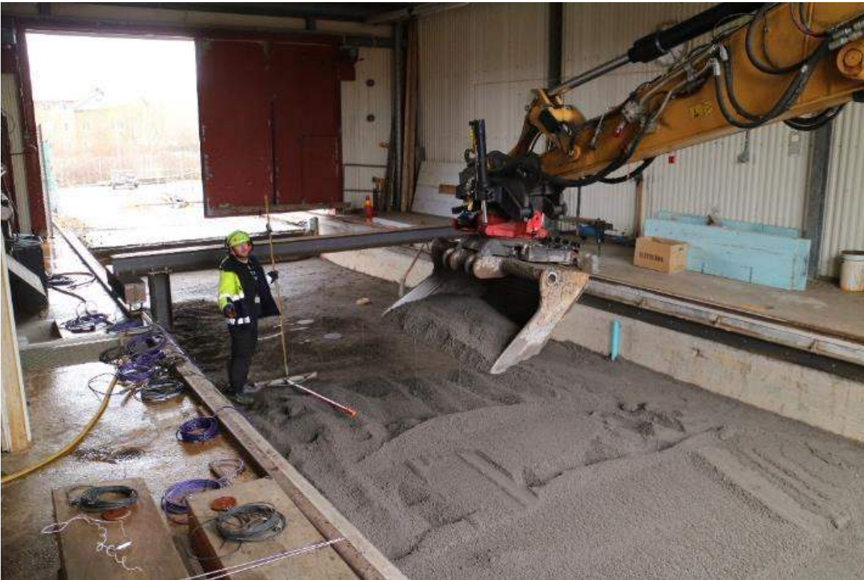
Utläggning obundet bärlager
